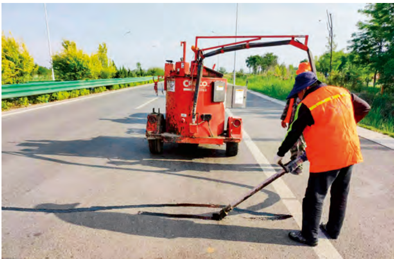
10月，县公路事业发展中心组织人员进行路面灌缝施工
