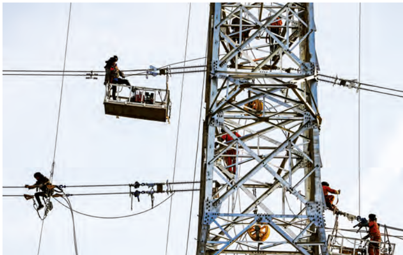
2月16日,供电公司建设220千伏万兴站110千伏配出工程
